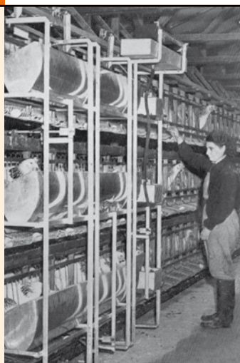
'Cafetariabatterij', één van de eerste legbatterijuitvoeringen, een innovatie die in de jaren '50 uit Amerika werd overgenomen. Bron: E.H. Ketelaars, Historie van de Nederlandse pluimveehouderij, Barneveld 1992.
